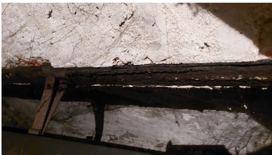
Rys. 5.3 Korozja belki stalowej podpierającej strop nad piwnicą – rozwarstwiona w wyniku korozji półka górna.
