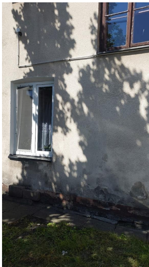
Rys. 5.7 Zawilgocenie ściany w strefie cokołowej.
