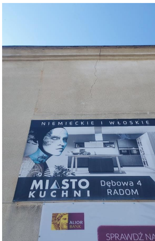
Rys. 5.16 Pionowe zarysowanie ściany północnej.
