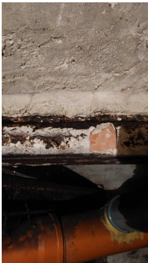
Rys. 5.1 Korozja belki stalowej podpierającej strop nad piwnicą.
