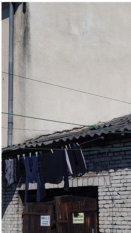
Rys. 5.10 Odspojenie tynku na granicy ściany budynku i przybudówki.
