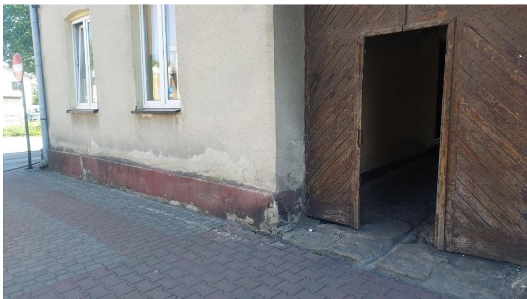
Rys. 5.8 Zawilgocenie ściany w strefie cokołowej.
