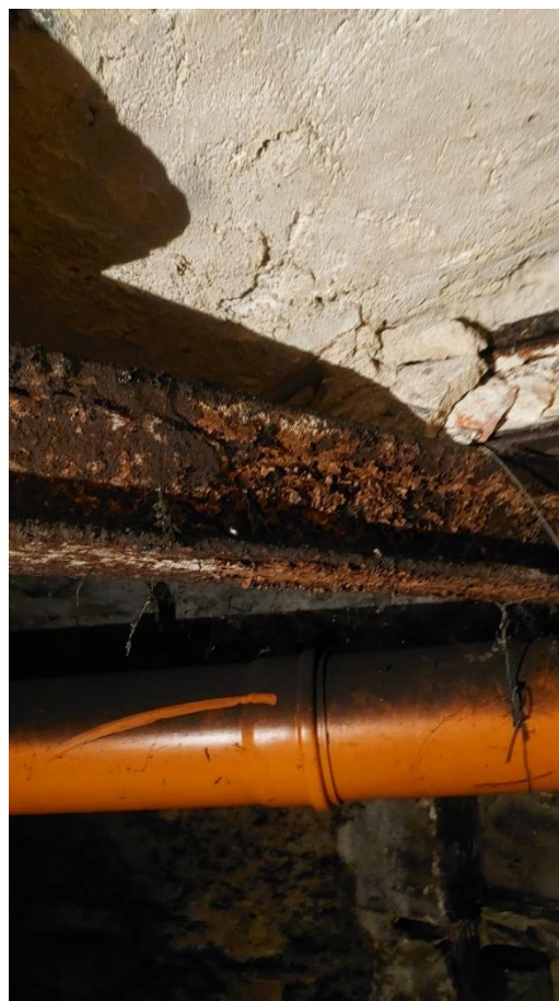
Rys. 5.2 Korozja belki stalowej podpierającej strop nad piwnicą.
