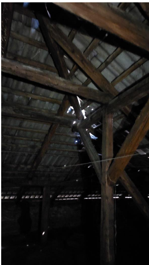
Rys. 5.6 Nieszczelne pokrycie dachu płytami z eternitu.
