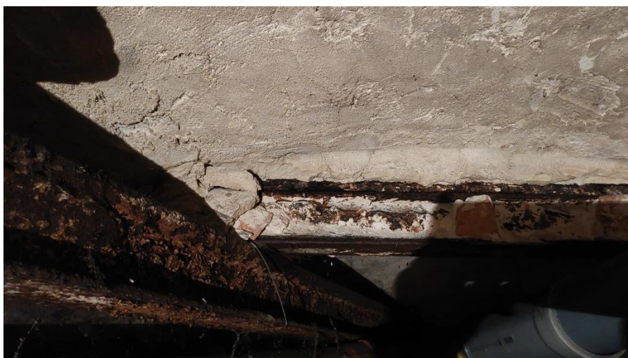
Rys. 5.4 Korozja belki stalowej podpierającej strop nad piwnicą.
