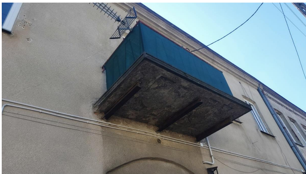
Rys. 5.9 Korozja belek podpierających balkon.
