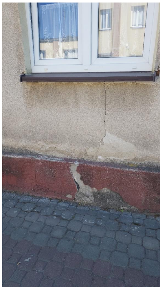
Rys. 5.13 Zarysowanie w strefie podokiennej.
