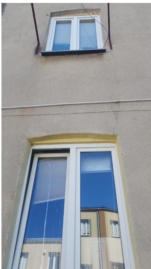
Rys. 5.14 Zarysowanie nad oknem.
