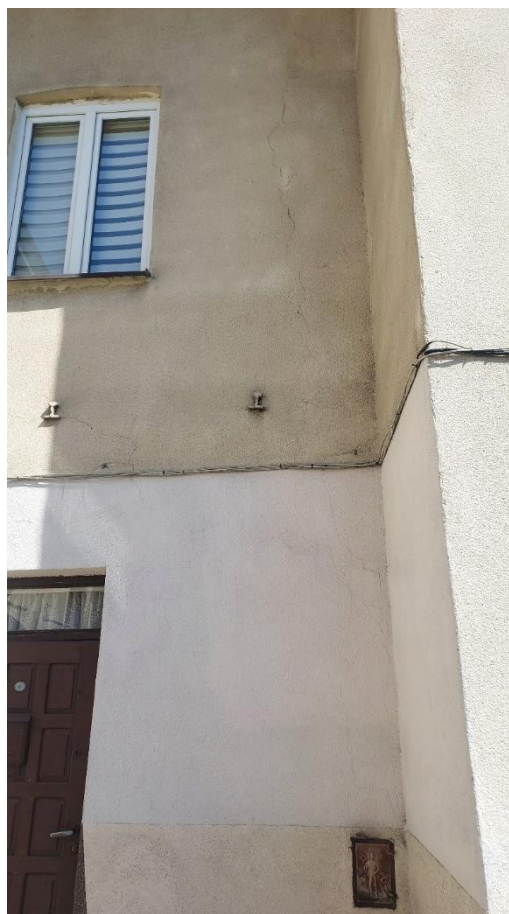
Rys. 5.11 Zarysowanie w narożu budynku.
