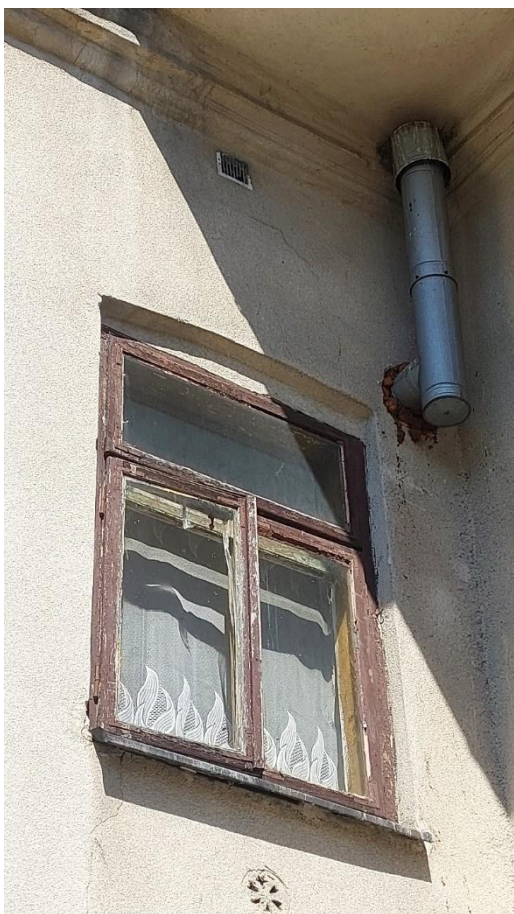
Rys. 5.12 Zarysowanie nad oknem.
