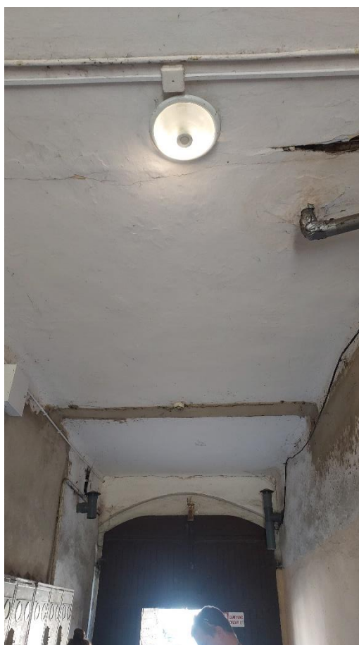
Rys. 5.5 Zarysowania i odspojenie tynku na stropie nad wejściem.
