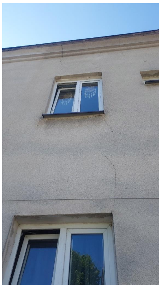
Rys. 5.15 Zarysowanie w strefie podokiennej.
